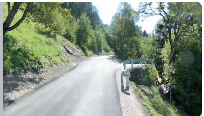
Verstärkte Tragschicht, geordnete Wasserhaltung, zusätzliche Ausweichen, Leitschienen an Gefahrenstellen und die zeitgemäße Neugestaltung von Straßenanbindungen erhöhen die Funktionalität der „neuen“ Alten Iselsbergstraße deutlich.
