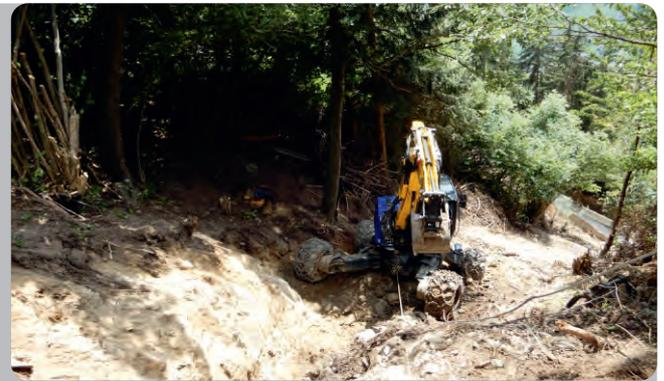
Mangelhafte Standfestigkeit erforderte abschnittsweise den Neuaufbau des Straßenkörpers, der erfolgte in Form der Bauweise mit „Bewehrter Erde“ (Bild links). Oberflächenentwässerungskanal, LWL-Leerverrohrung und neue Trinkwasserleitung in schwierigstem Baugelände.
