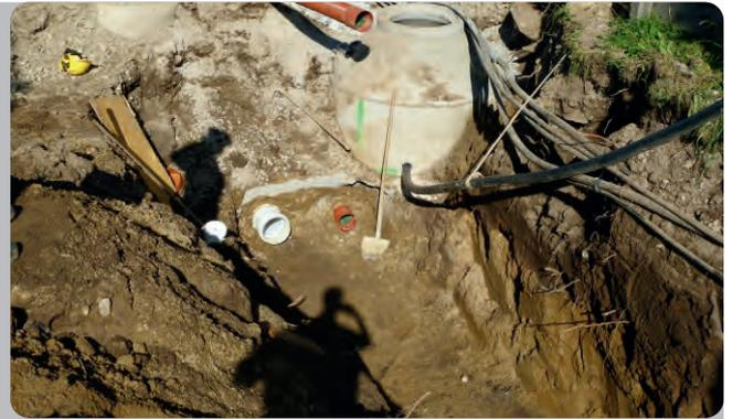
Neueinbindung der Wasserversorgungsleitung in den Hochbehälter Obergöriach. Die Vielzahl an bestehenden Leitungen und der Einbau zusätzlicher Versorgungsleitungen war für die Bauausführenden eine besondere Herausforderung (rechtes Bild).
