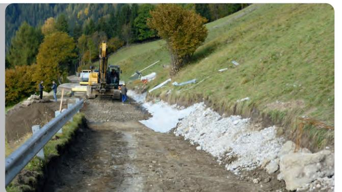
Oberflächenentwässerungskanal wurde eingebaut, Feldabfahrten und zusätzliche Ausweichen errichtet sowie eine deutlich verstärkte Tragschicht eingebaut
